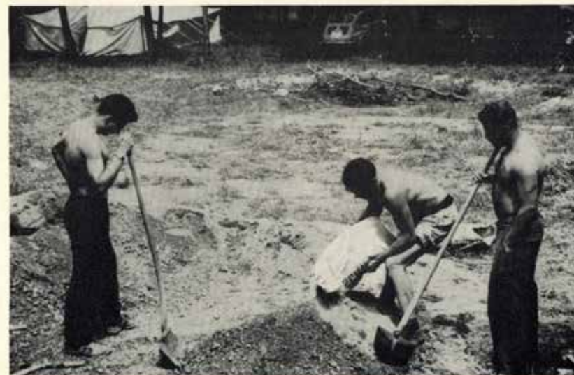
Bauarbeiten für's „Häuschen“
